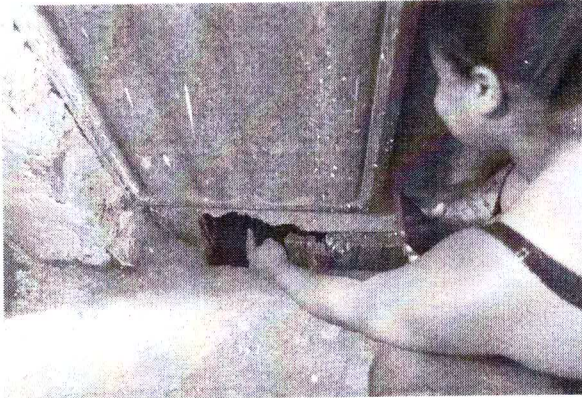
Rachaduras e a abertura do solo surgiram no residencial Vale do Mundial localizado no bairro
