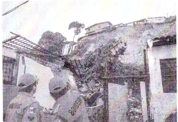
Comunidade São Rafael será uma das beneficiadas com obra de engenharia, informa Defesa Civil
