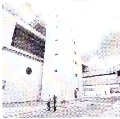
Construção do Hospital Metropolitano é um dos investimentos feitos
